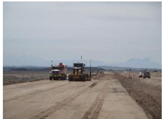
Foto N° 06 Ejecución tercera capa DM 80,000
