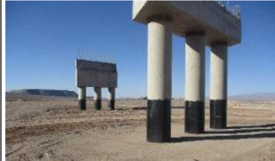
Foto N° 02 Enlace Acceso Sur Sierra Gorda
